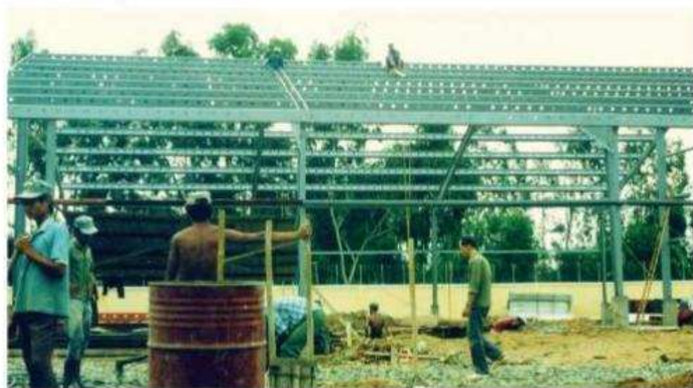
Khởi công xây dựng nhà máy
